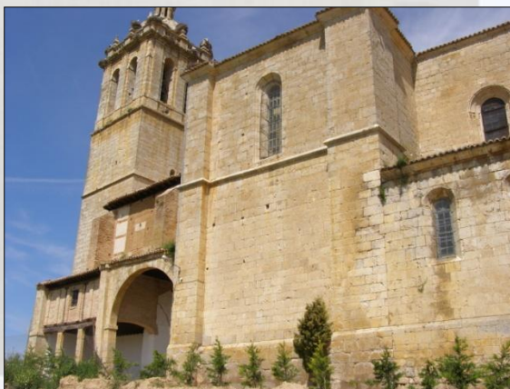
Foto 1. Exterior de la Iglesia
